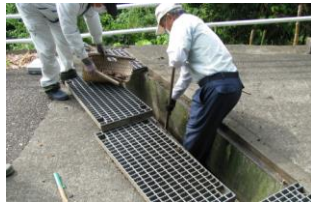
側溝泥土出し作業
